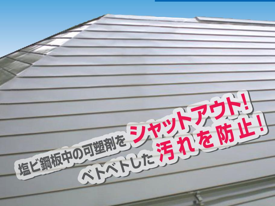
塩ビ鋼板(塩化ビニルフィルムラミネート鋼板)は、鋼板・亜鉛めっき鋼に塩化ビニル樹脂を被覆したもので、屋根材をはじめ建築分野で広く用いられている部材です。
