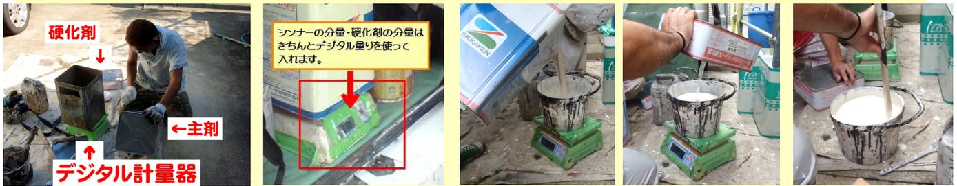
主剤と硬化剤の重さを計算して使う分量の塗料を作ります。
