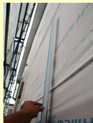
外壁の下に貼ってある防水紙貼り合せの目印も付いている
