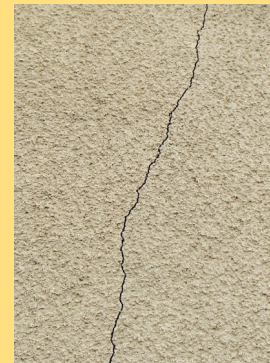
モルタル外壁のヒビ
