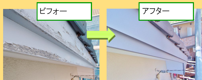
木の破風板にトタン板金を巻いてしまえば長持ちします
