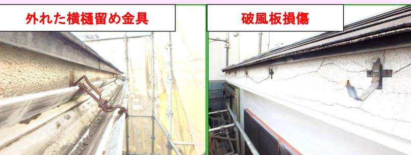
特に金属製の横樋留め金具の場合は経年劣化や雪害などで金具自体が徐々に変形してしまいます。軽微な変形の場合は元の位置に調整できますが、何度も調整を行ったり腐食が酷い場合や大きな変形の場合は元に戻すことは出来ません。こうなった場合は交換となります。また留め金具は建物の破風板（鼻隠し）と呼ばれる部分に打ち込んで
