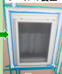
シールの養生
