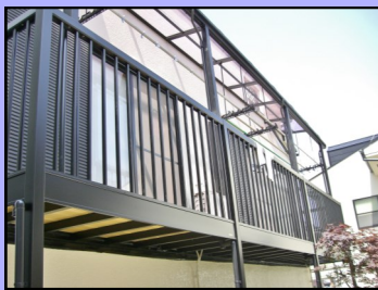
鉄のバルコニーをアルミ製に交換した事例
