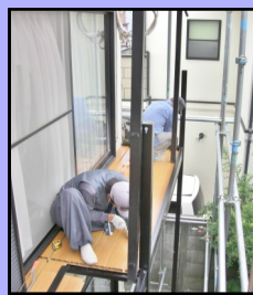
鉄のバルコニーをアルミ製に交換した事例
