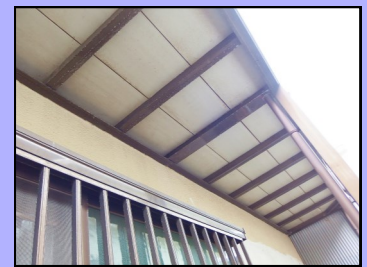
床板から雨水が落ちること
