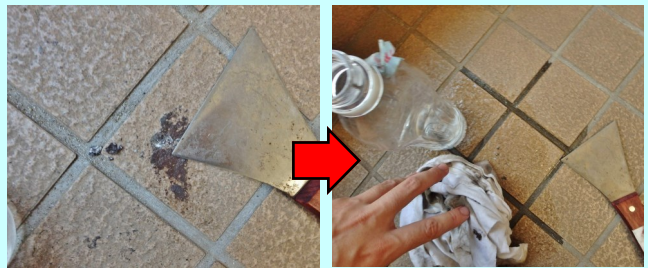
↑塗料がついたタイル床を掃除中。 シンナーをウエスに含ませて掃除します。
