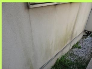
窓枠の下に垂れ下がるように線のような汚れがついているのを見かけたことはありませんか？ これは雨が降った際に窓のサッシについた雨粒が汚れと混じりながら外壁に垂れる「伝い水」が原因の汚れです。この「伝い水」が外壁に付かないよう、滑り台のような形で外壁の外側に落とすことができるのがツタワンDなのです。
