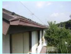
屋根の左右が「ケラバ」なら、上は「棟」、下が「軒先」になります。この軒先の側面についているのが「鼻隠し」。破風板の真ん中で、雨樋を取り付けるのはこの鼻隠しです。
