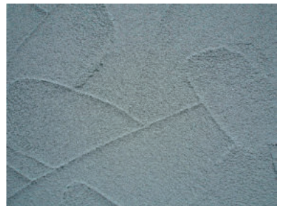
ブロックダム
