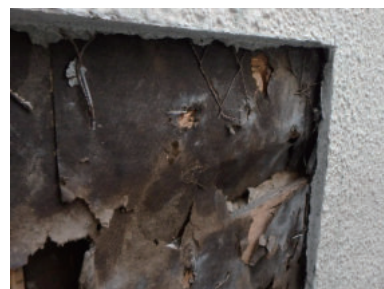
昔の防水シートは黒く、【アスファルトフェルト】と言う。(透湿性は無い)
