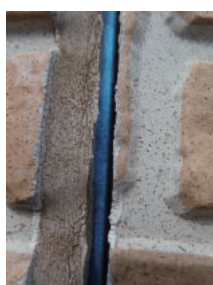
コーキングの寿命は約10年。このような亀裂では雨が降る度に外壁内部に水が浸入してしまう。
