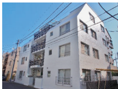
鉄筋コンクリート(吹き付け下地)
