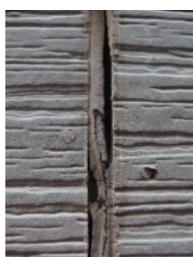
コーキングの寿命は約10年。このような亀裂では雨が降る度に外壁内部に水が浸入してしまう。
