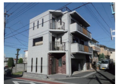
鉄筋コンクリート(マスチック下地)
