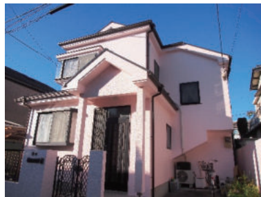
木造住宅(モルタル下地)
