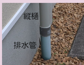
雨樋と排水管直結
